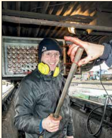
Einbau der Heizlanzen in das Heizregister. Hier auf dem Kanal stehen normalerweise die Dampflokomotiven zum Ausschlacken und Auswaschen.
