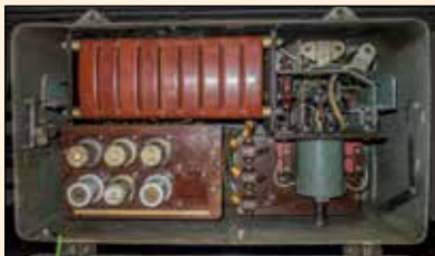
Elektromechanische Mehrspannungswähleinrichtung mit mittleren Geräteträger auf der Abteilseite unter dem Wagen („Umschalt-schützekasten“ Nr. 27 im Wirkschaltplan).
