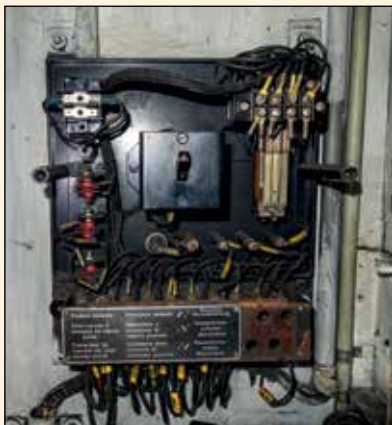
Heizungssteuerung im Schaltschrank ohne Abdeckung.
